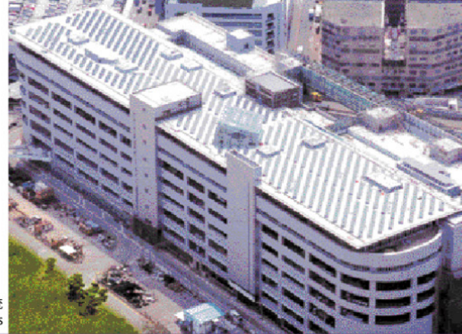
機電署新總部大樓天台的 350kW 光伏系統 350kW PV system on the roof of new EMSD Headquarters
